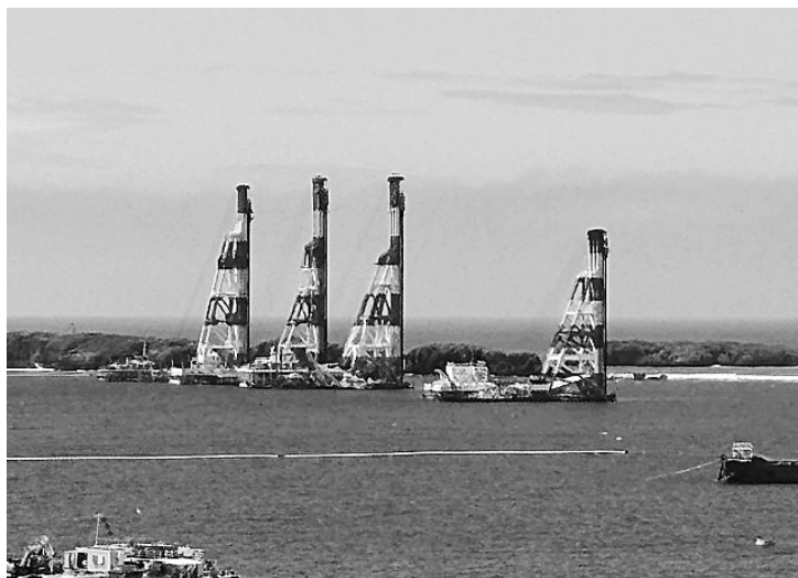
辺野古新基地建設現場
